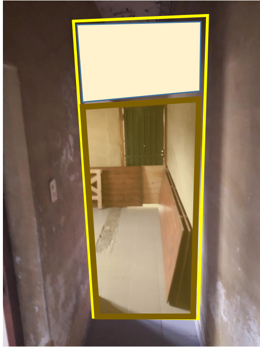
pasillo a colocar puerta nueva con cierre de durlock en la parte superior
